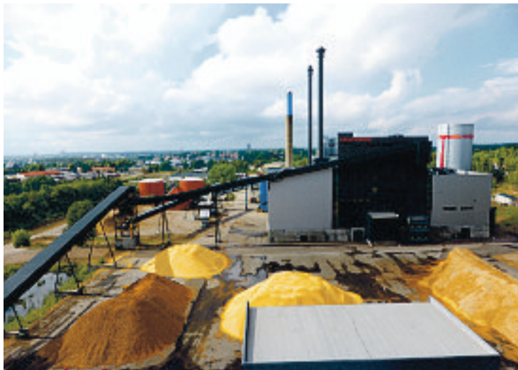
Centrale op biobrandstof van Vaxjo Energi in Sandvick
